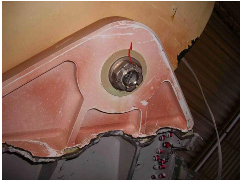
Figure 49 : chape arrière droite : cisaillement du fuselage au droit des cadres forts 86-87
